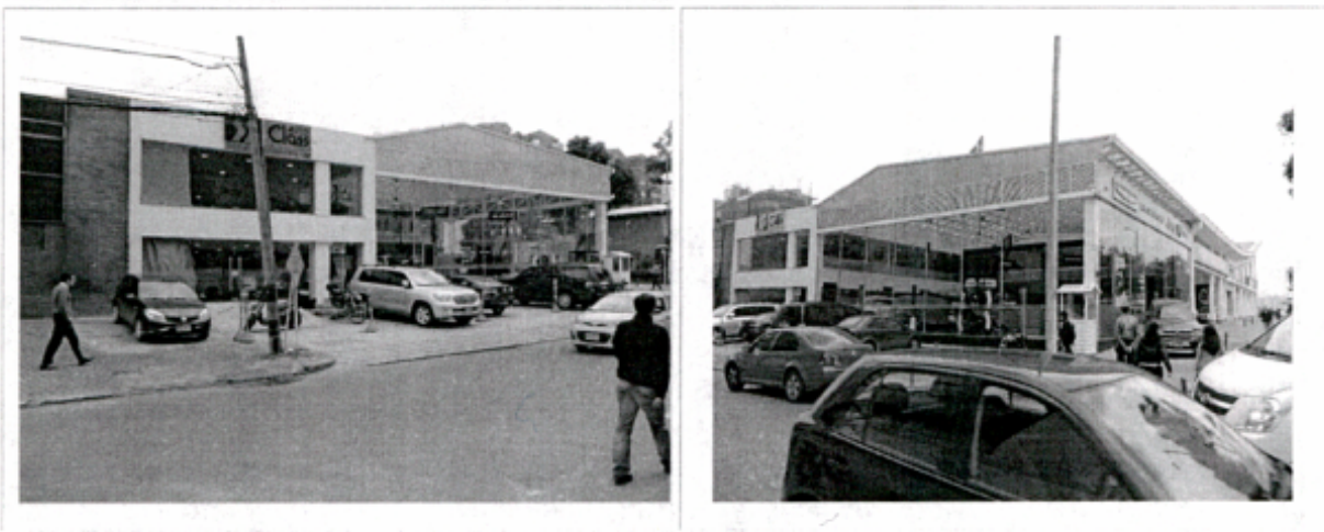
Registro Fotográfico: Predio ubicado en la Avenida Carrera 11 No. 9. Localidad de Chapinero Construcción que no corresponde a lo aprobado en el acto administrativo expedido por la Curadora Urbana No. 2 (P).
